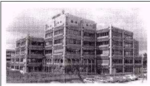
Figuur 3 Gevelbekleding kleur geanodiseerd
